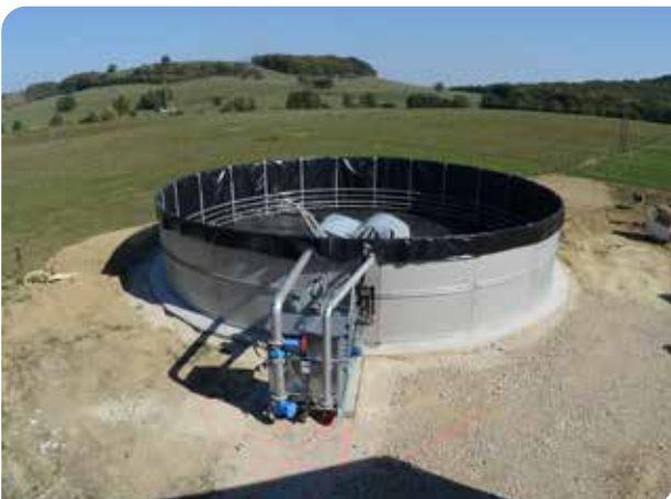
3ème jour : achèvement des travaux pour la technique
