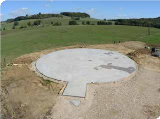
1er jour : dalle préfabriquée réalisée par le maître d'ouvrage
