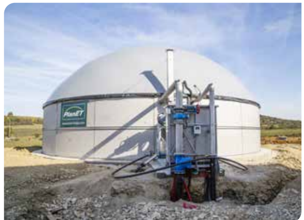
7ème jour : montage et mise en service du toit avec collecteur biogaz. Entre-temps, le réseau d'approvisionnement a déjà été posé.
