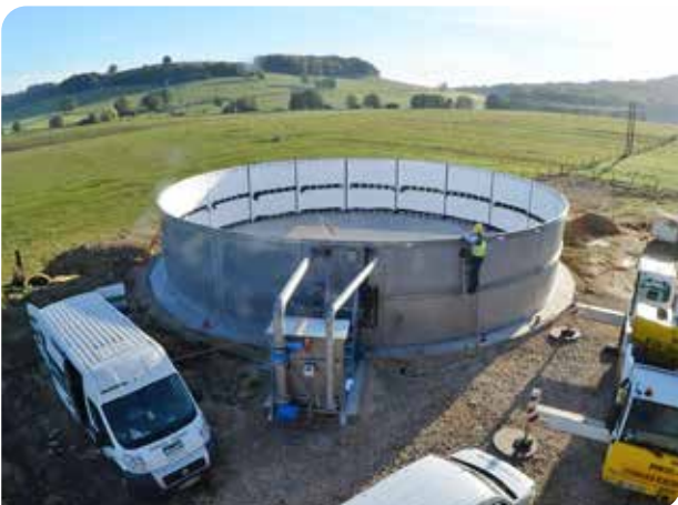
20h : les éléments latéraux sont montés
