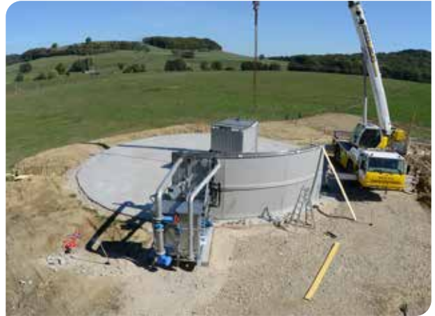
Midi : mise en place du module technique et des premiers éléments latéraux
