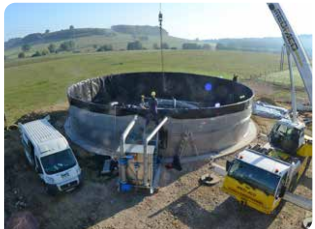
2ème jour : revêtement intérieur du réservoir
