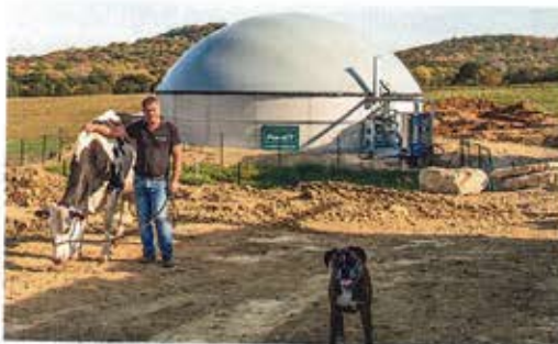
Die neue Hofbiogasanlage Valentin von PlanET ist schnell aufgebaut.
