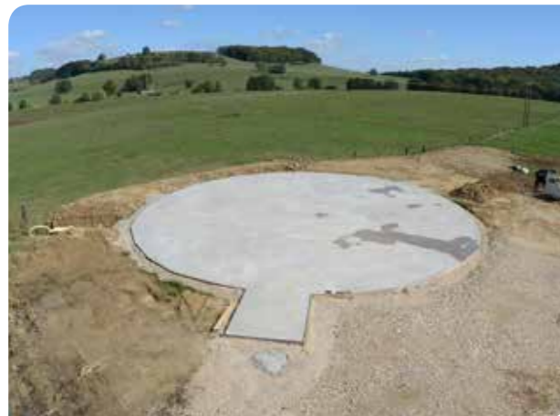
1. Tag: Vorgefertigte Bodenplatte durch den Bauherren
