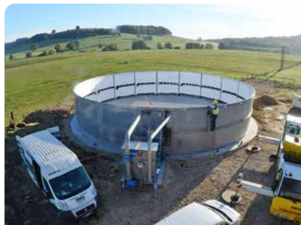
20.00 Uhr: Seitenelemente sind montiert
